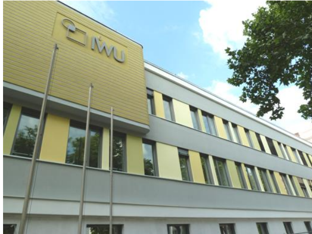
Ansicht des neuen IWU-Hauses, das mit Passivhaus-Komponenten saniert wurde
